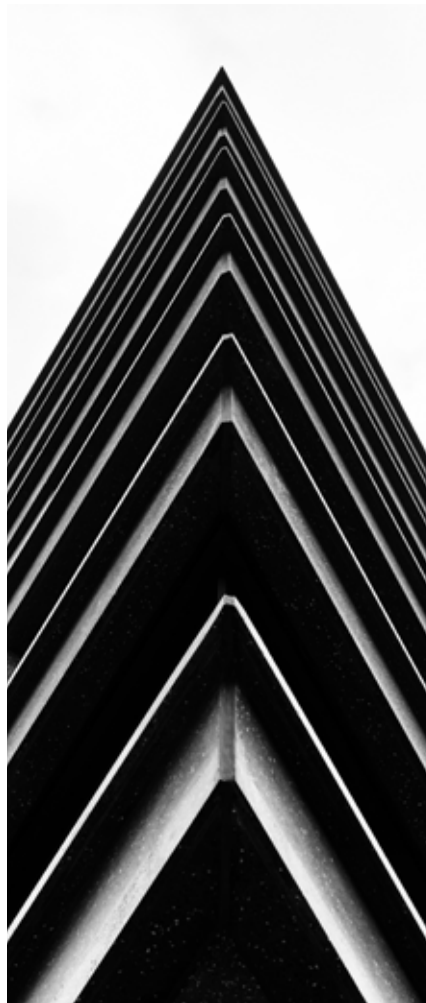
De driehoekige vorm van het perceel geeft Antigoon een specifiek karakter.
