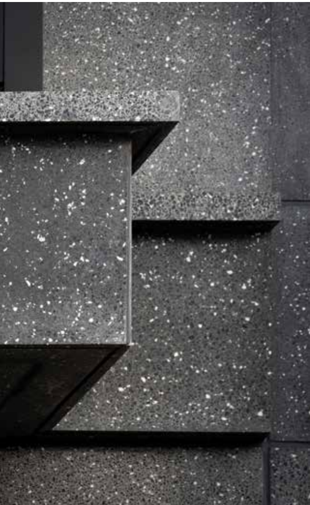
De gevelpanelen zijn uitgevoerd in gepolijst, wit gespikkeld, antracietkleurig architectonisch beton.
