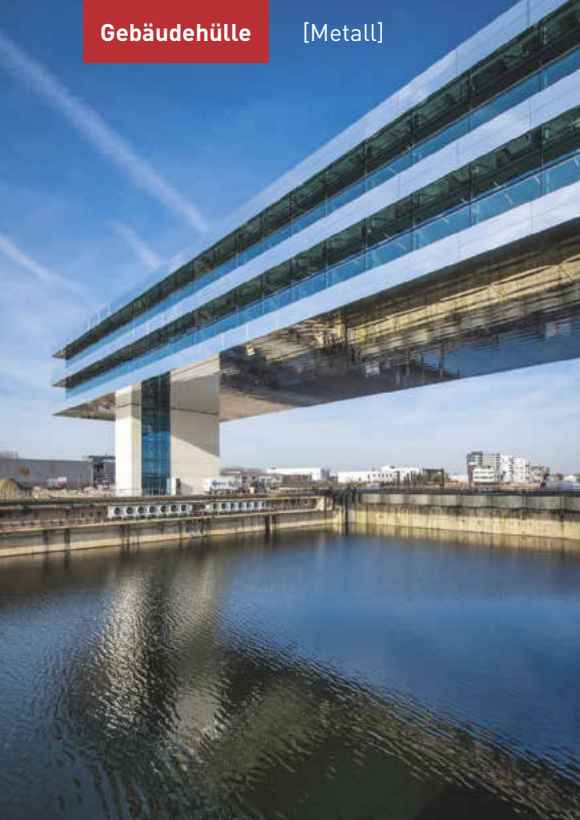
20 m über dem Wasser glänzt die Gebäudehülle dank der silbrigen Aluminiumverkleidung.
